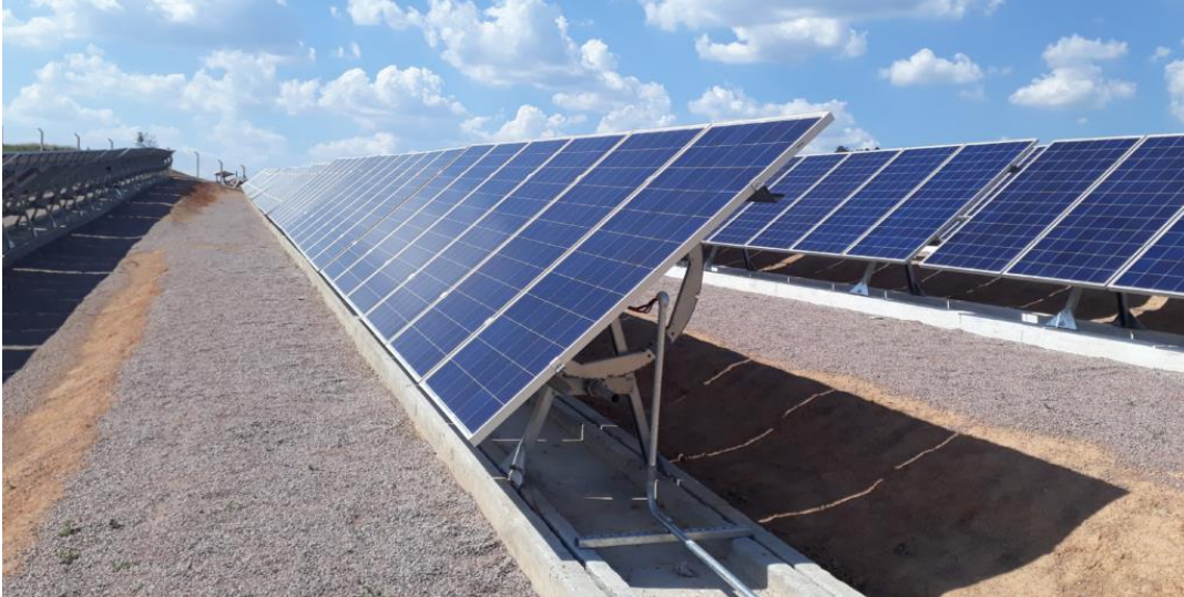
Figura 2.1 - Exemplo de seguidor solar com um grau de liberdade
