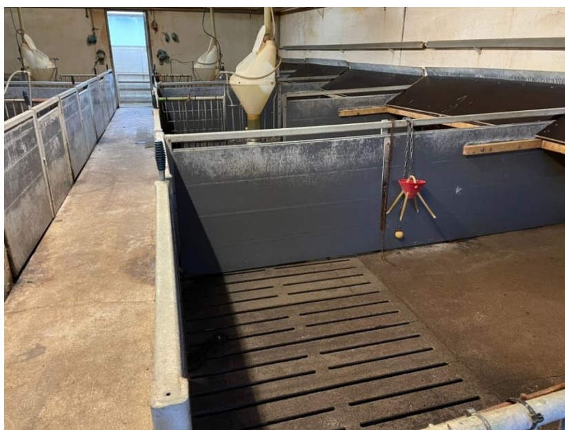
Figura 4: Instalação de creche, fazenda Dalhavegaard, após o processo de limpeza e desinfecção.
