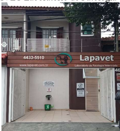
Figura 27 – Fachada do LAPAVET Laboratório de Patologia Veterinária, Santo André – SP.
