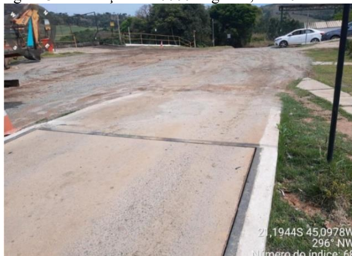
Figura 3 – Balança UL 40000 Digitron, até 40 toneladas.
