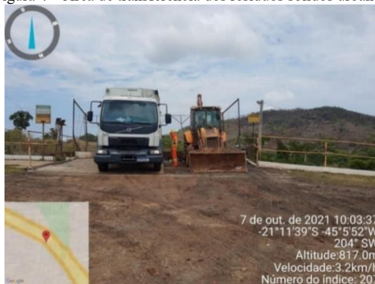
Figura 4 – Área de transferência dos resíduos sólidos urbanos.
