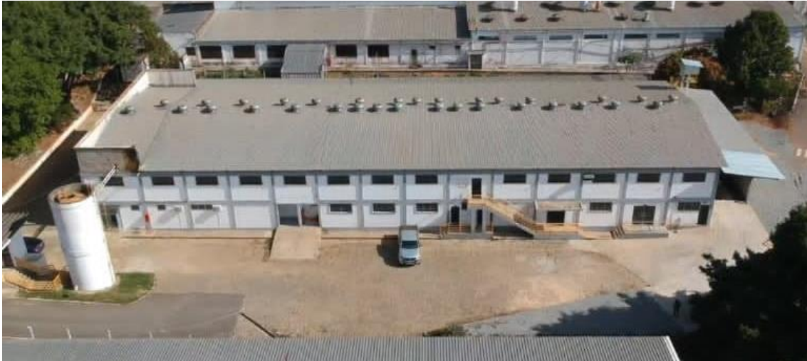
Figura 1 – Fábrica vista lateral e por cima.
