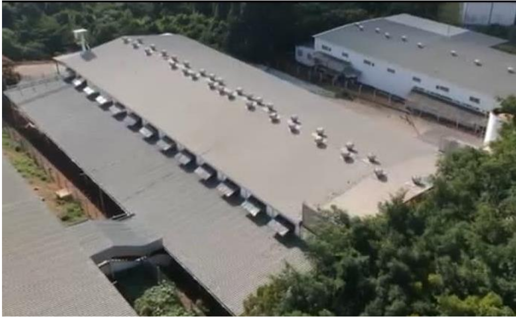
Figura 3 – Vista lateral, local de carga e descarga dos caminhões da fábrica
