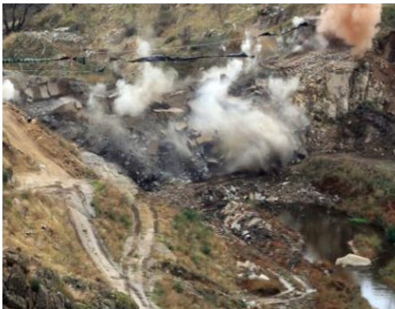
Foto 5 – Remoção Barragem Robledo de Chavela
