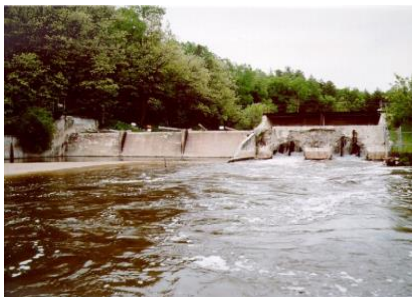
Foto 3 – Barragem Stronach durante a remoção gradual
