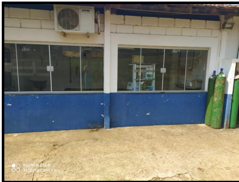
Figura 5 - Bloco cirúrgico do Centro Médico de Cavalos, vista lateral.
