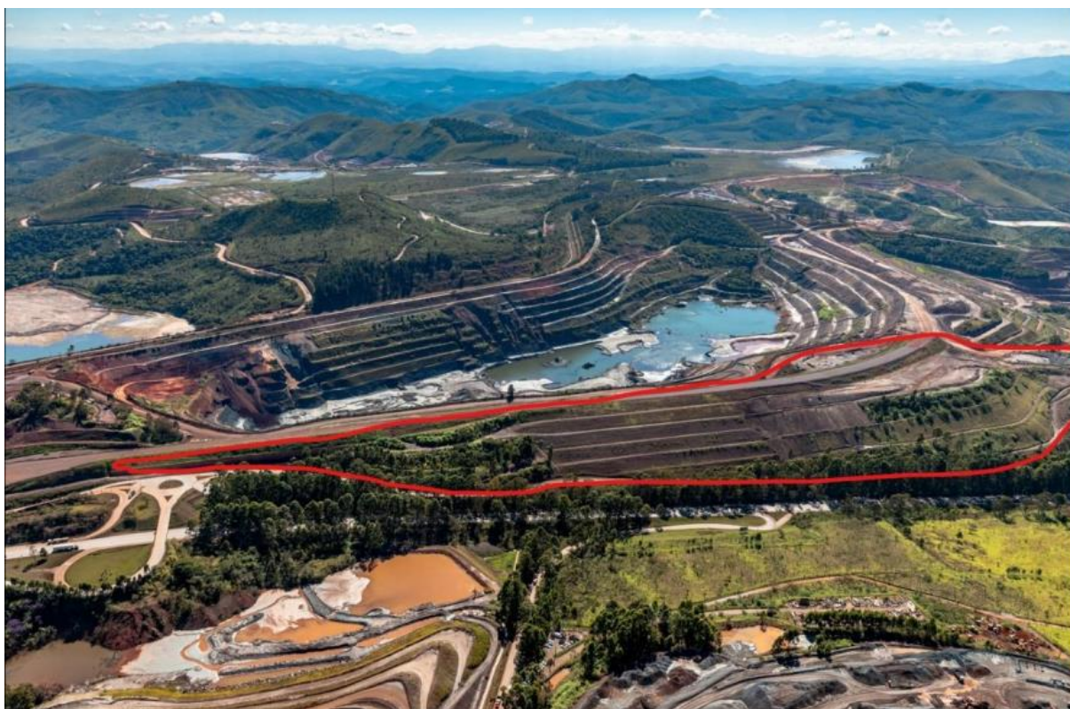
Figura 14: Vista geral da PDE C.
