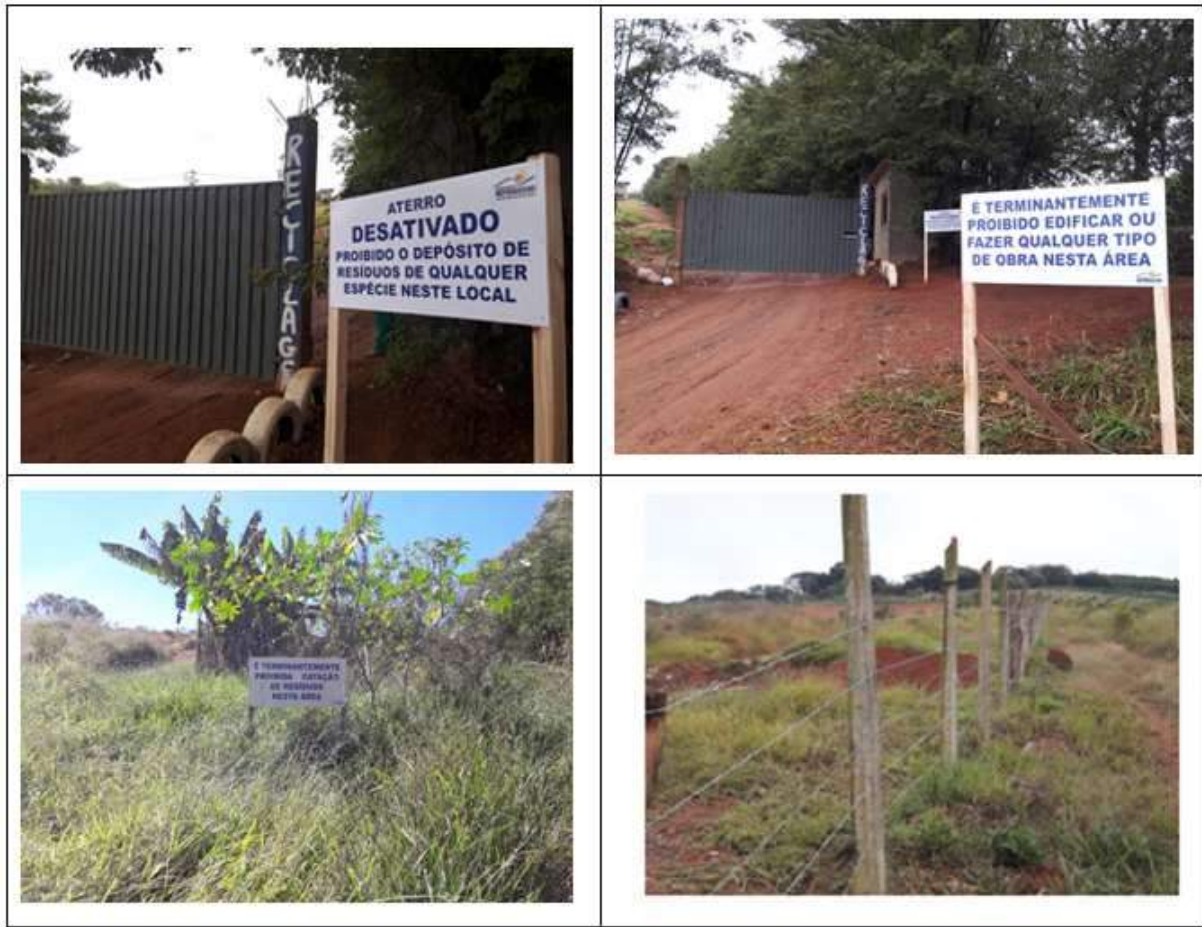
Figura 3 - Situação atual da área de Compl de RSU
