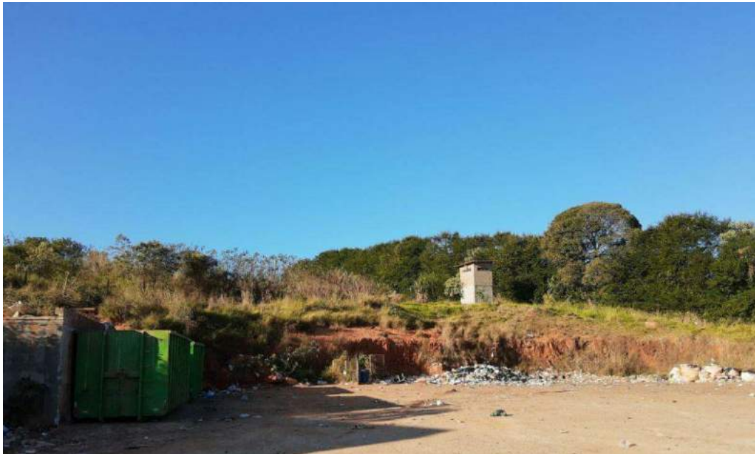
Figura 5 - Pátio da estação de transbordo de resíduos sólidos.
