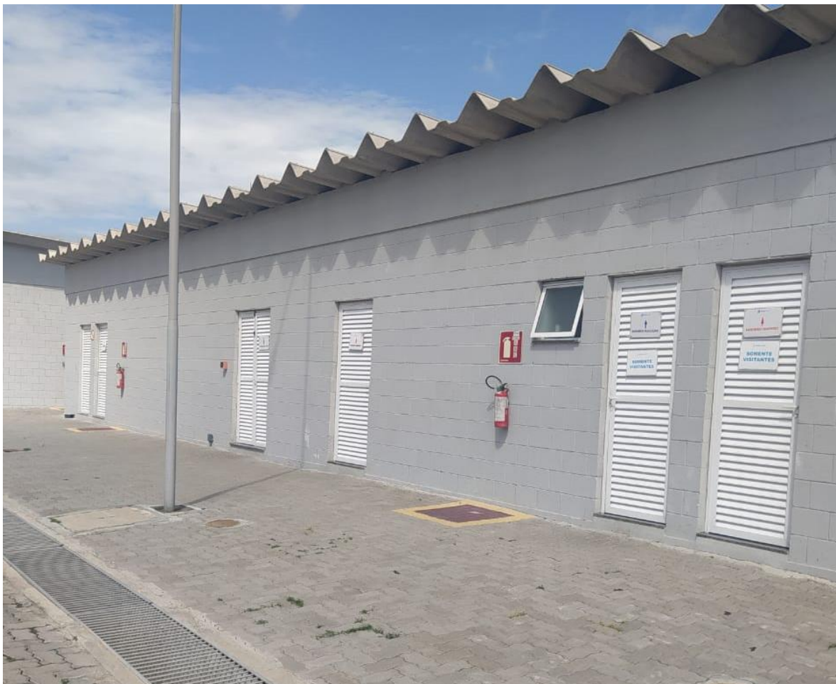
Figura 4 Refeitório, vestiários e banheiros na área externa
