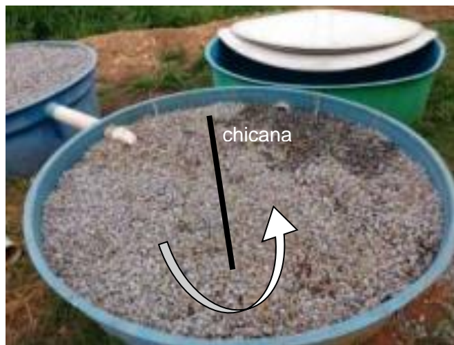
Figura 14- SACs instalados no Parque Francisco de Assis com entrada da canalização dada a 0,15 m da altura da borda do tanque em 2016, e ilustração sobre a chicana.
