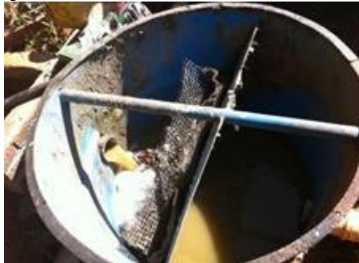
Figura 5- Gradeamento da unidade de tratamento do PFA
