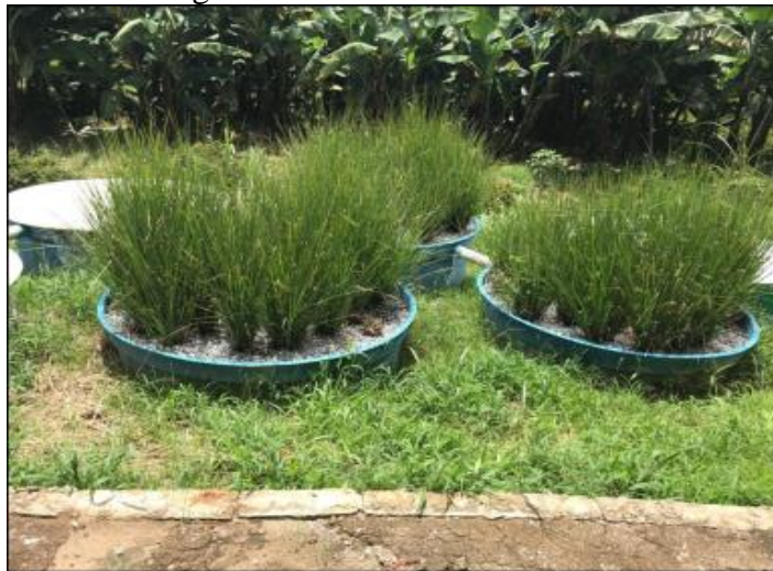
Figura 10- Sistemas alagados construídos da unidade de tratamento do PFA
