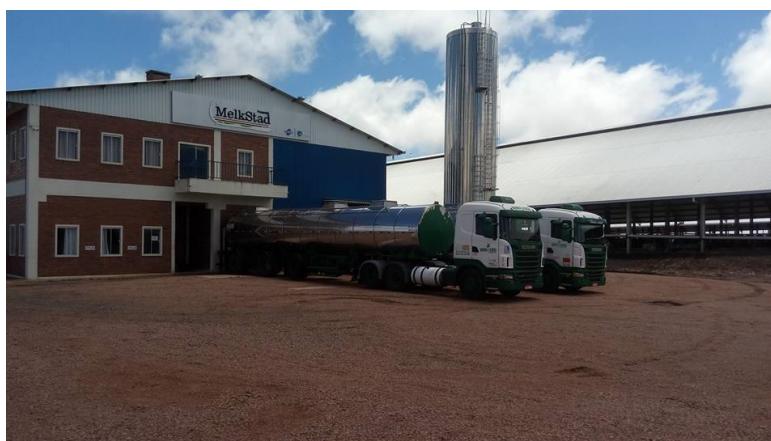
Figura 1- Fachada da Fazenda Melkstad
