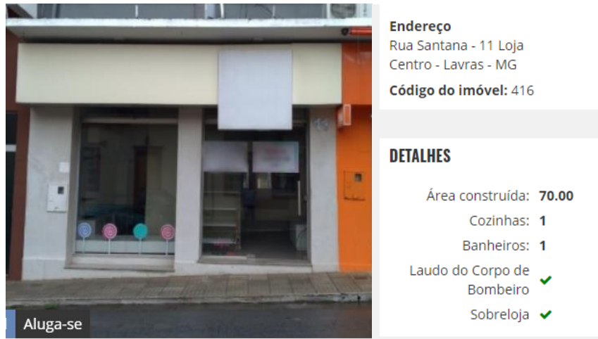
Figura 16: Fachada e dados do imóvel
