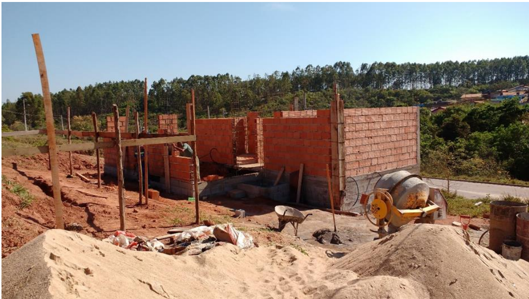
Figura 14 - Alvenaria de bloco cerâmico vazado com pilares em forma de madeira.
