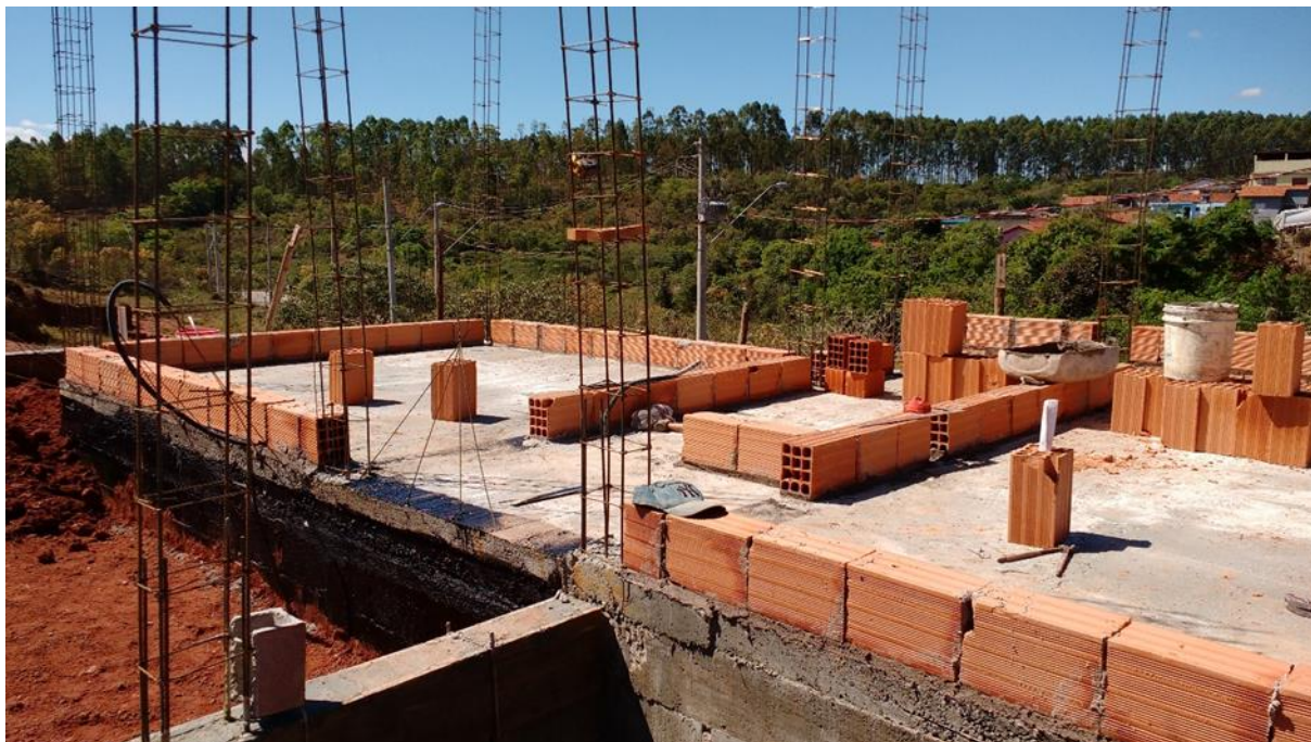
Figura 12 – Início da execução da alvenaria de blocos cerâmicos vazados.
