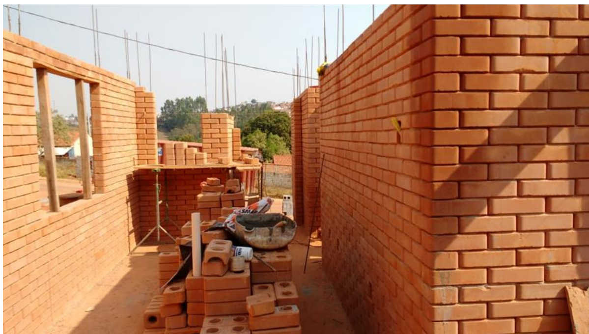
Figura 13- Alvenaria tijolo solo-cimento com uso de armaduras embutidas.
