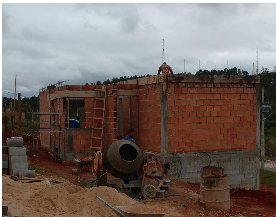
Figura 16 – Alvenaria de vedação com utilização de vigas e pilares para receber as cargas da laje.
