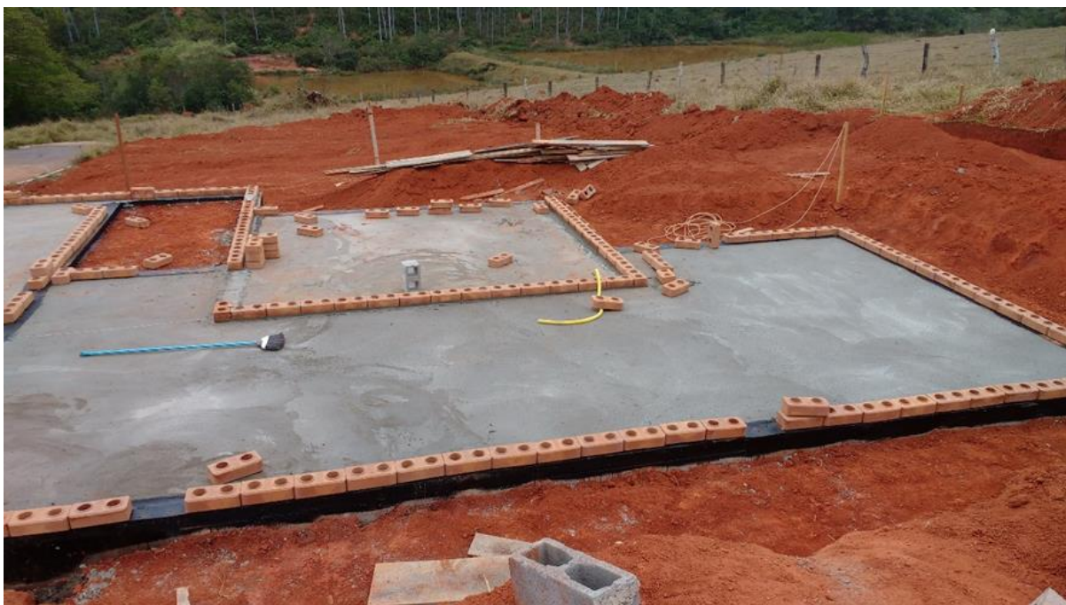
Figura 11- Início da alvenaria de tijolo solo-cimento.
