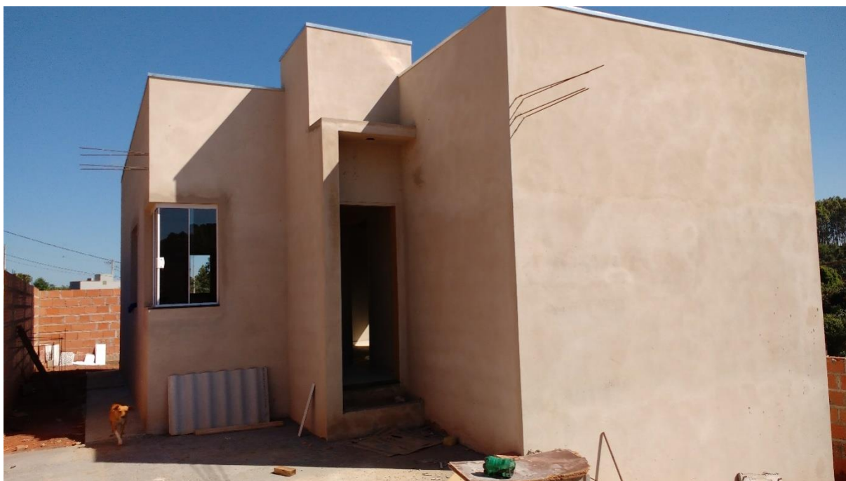
Figura 18- Paredes externas com revestimento em reboco da obra 2.
