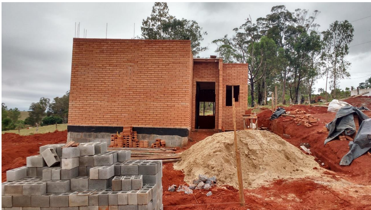
Figura 17 – Paredes externas da Obra 1 com tijolos aparentes.
