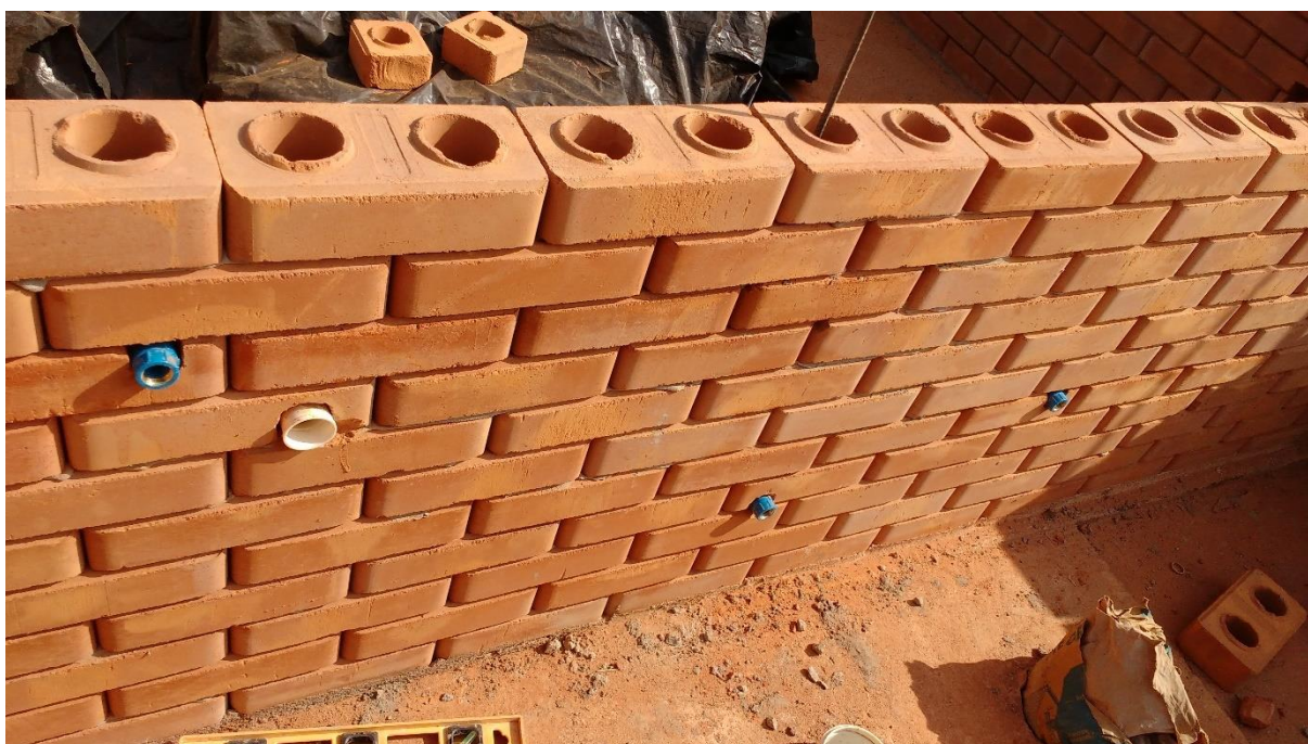
Figura 2 - Tijolo de solo-cimento modular com 2 furos, com instalação hidráulica.
