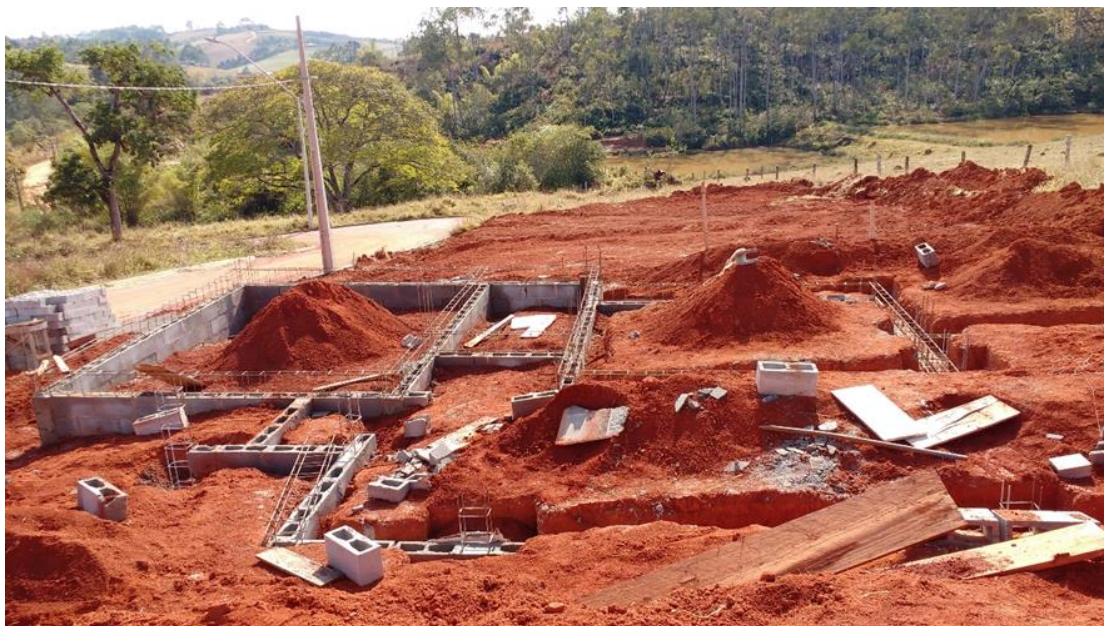
Figura 6- Execução da fundação da obra 1
