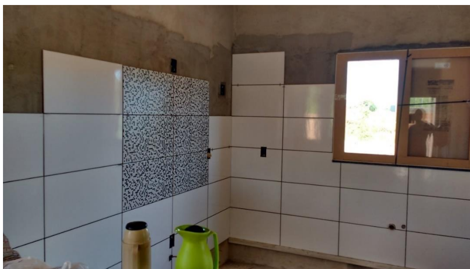
Figura 10- Execução de revestimentos internos da obra 2.
