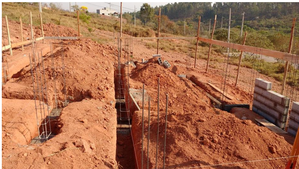
Figura 9 – Execução das vigas baldrame da Obra 2.
