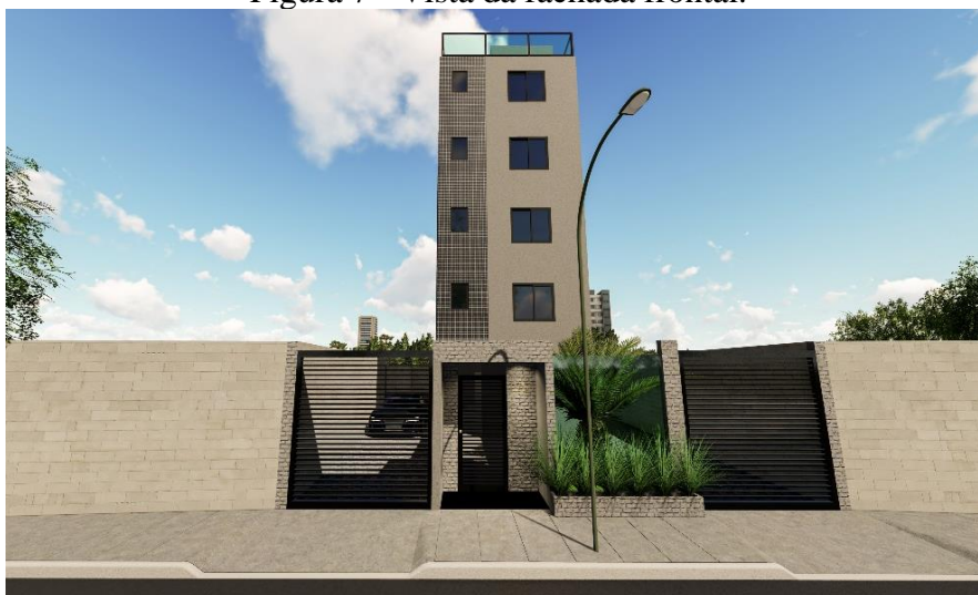
Figura 7 - Vista da fachada frontal.
