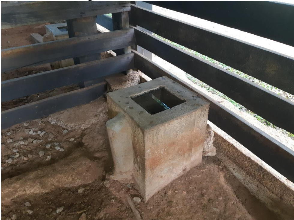
Figura 19. Bebedouros de alvenaria
