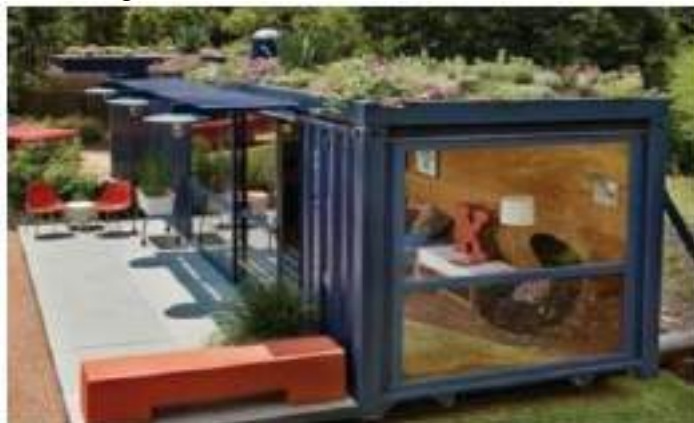
Figura 24 - Container com telhado verde.
