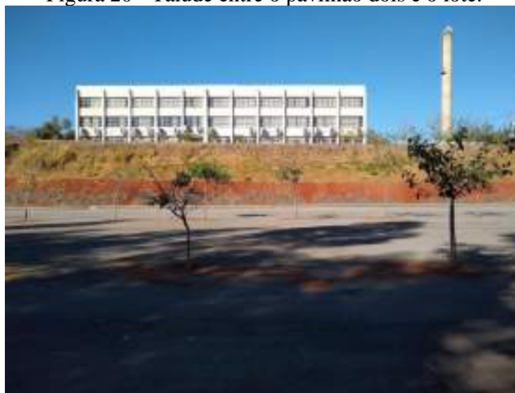
Figura 20 - Talude entre o pavilhão dois e o lote.
