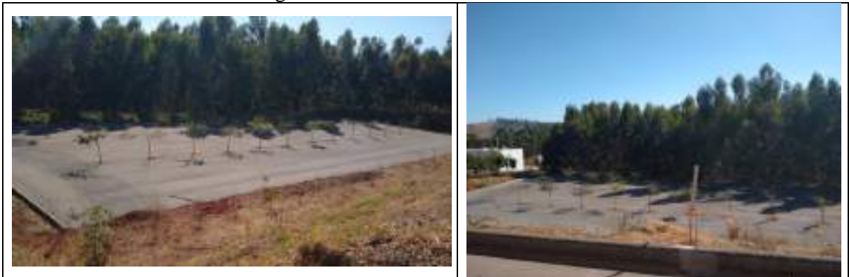
Figura 19 - Lote asfaltado e nivelado.
