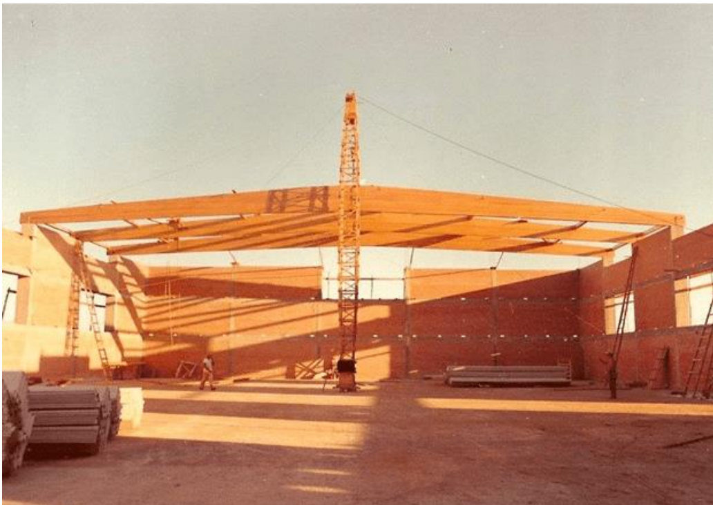
Figura 2.2 – Cobertura do ginásio de poliesportivo da Universidade de Passo Fundo.
