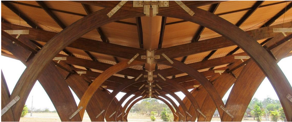
Figura 2.9 – Cobertura no Parque de Exposições de Brasília.
