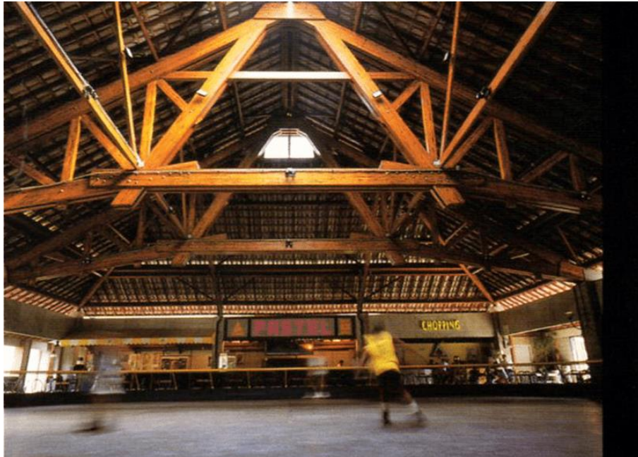
Figura 2.3 – Cobertura do Shopping Riviera em Bertiooga, São Paulo.
