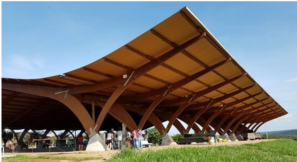
Figura 2.8 – Cobertura no Parque de Exposições de Brasília.
