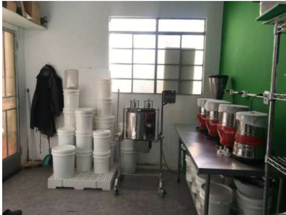
Figura 7 – Sala de máquinas.
