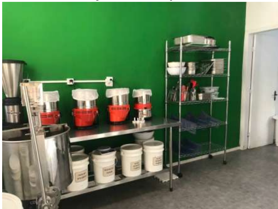
Figura 6 – Sala de máquinas.
