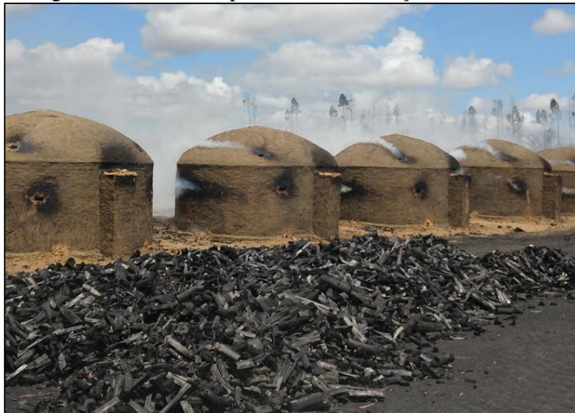
Figura 23 - Fornos da planta de carbonização em atividade
