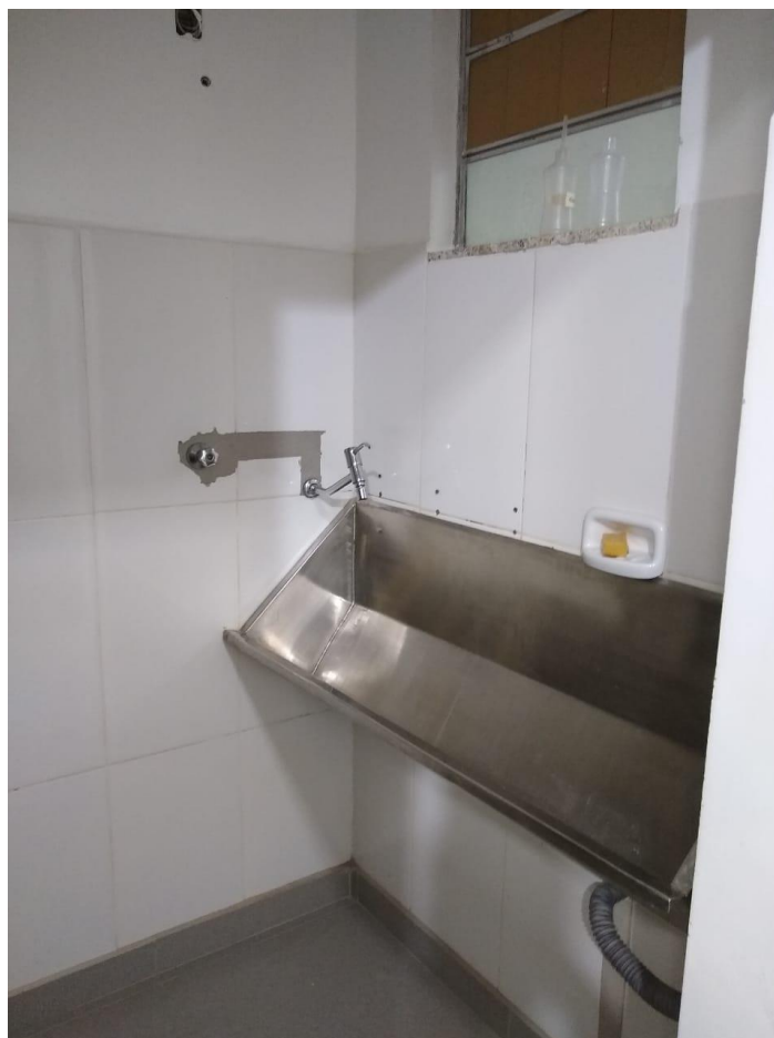
Figura 9 - Pia da Sala de Esterilização
