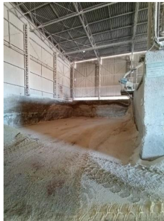
Figura 15 - Box Armazenamento de insumos
