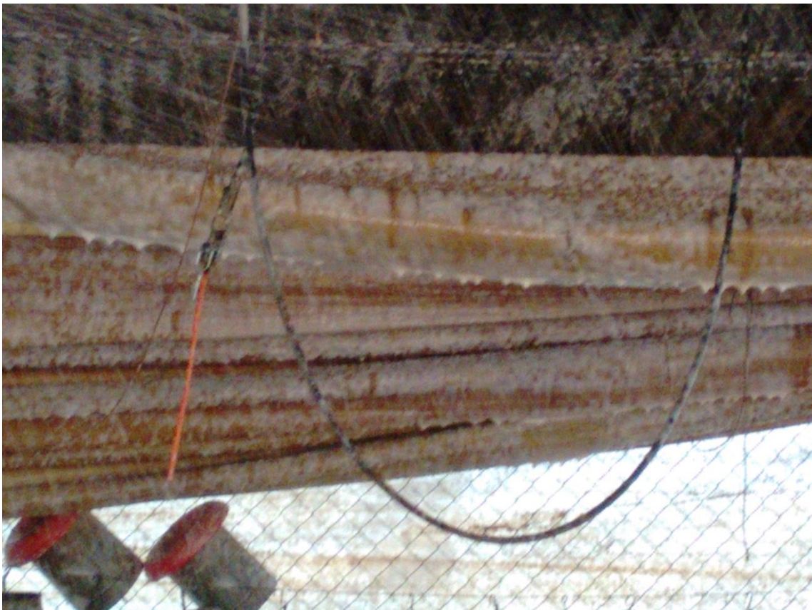
Figura 4 - Solução de glutaraldeído sendo aplicado na superfície do galpão.
