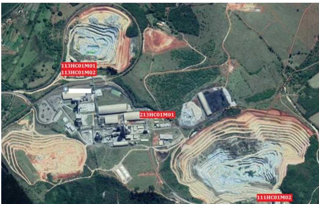
Figura 7 - Localização dos britadores na fábrica
