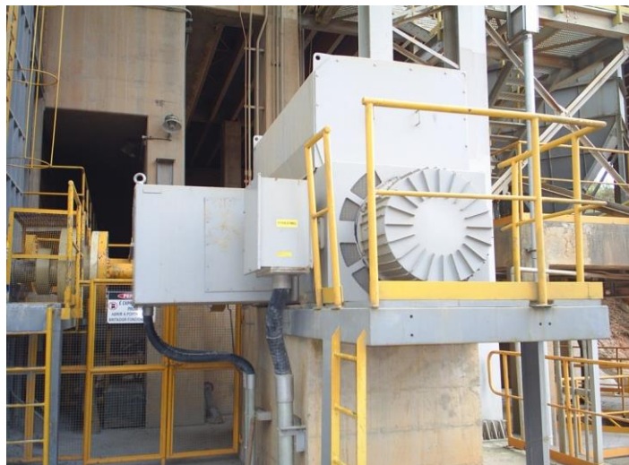
Figura 6 – Britador de calcário da mina 2
