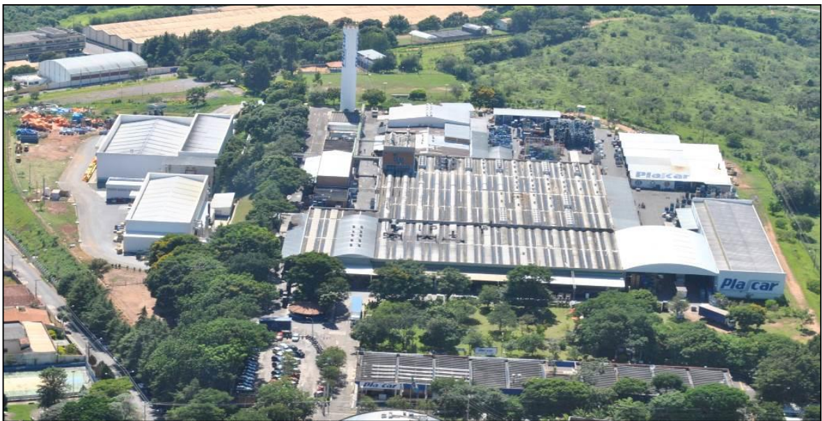
Figura 1 - Unidade de Varginha – MG.
