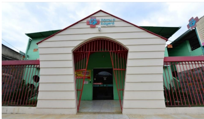
Figura15– Fachada da Clínica Veterinária Rômulo Edgard.
