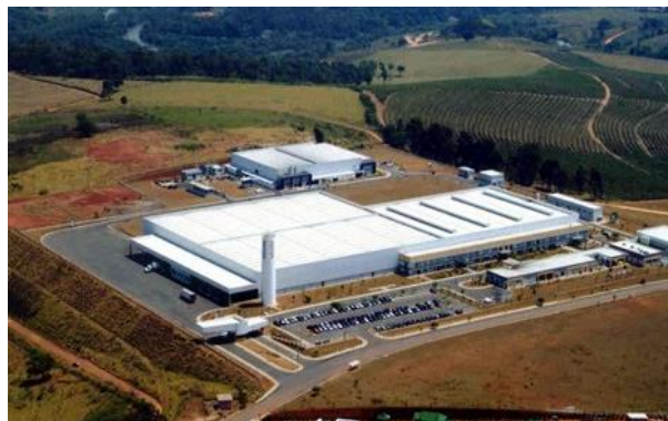
Figura 1 – Vista aérea da planta industrial em Varginha, MG.
