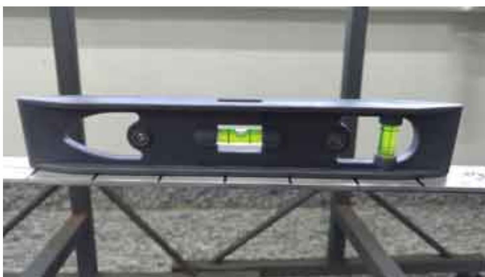
Figura 5.42 – Aferição do nivelamento da estrutura de viga.
