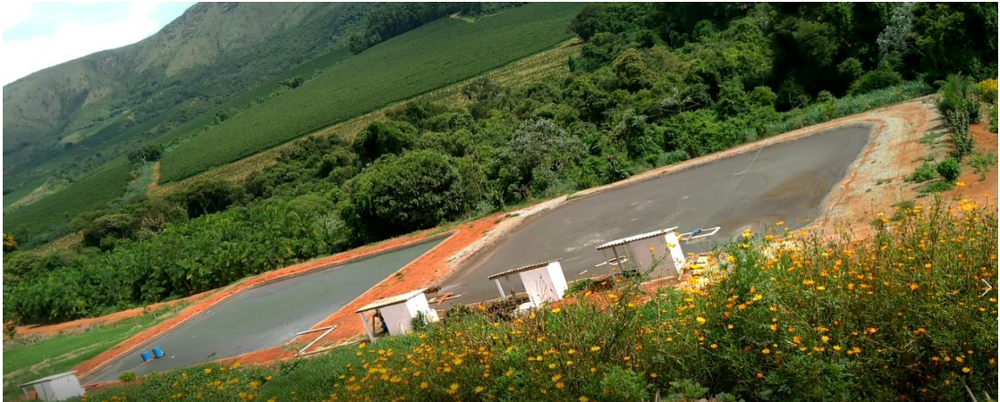
Figura 16- Tanques escavados 1 e 2 utilizados na armazenagem dos efluentes.
