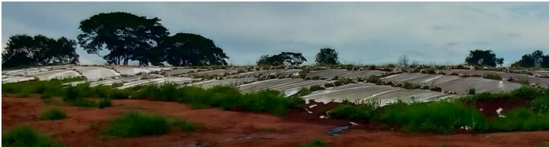
Figura 39- Silo superfície utilizado no armazenamento de milho e sorgo.
