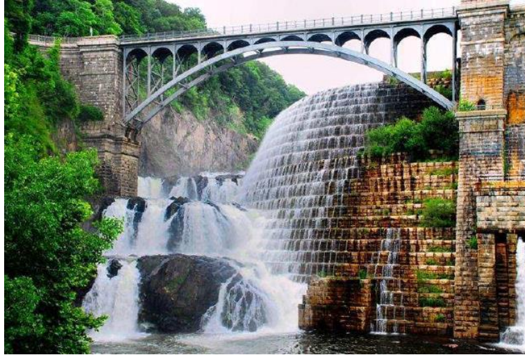
Figura 24 – Vertedor de cheias em Degraus da barragem de New Croton, EUA.
