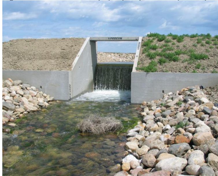
Figura 23 – Bacia de dissipação por queda abrupta simples.
