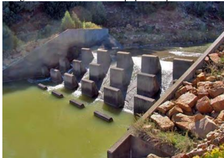
Figura 20 – Estrutura de dissipação do tipo USBR IX.
