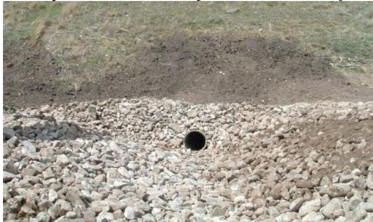
Figura 21 – Tapete de enrocamento a jusante de uma tubulação de fundo.
