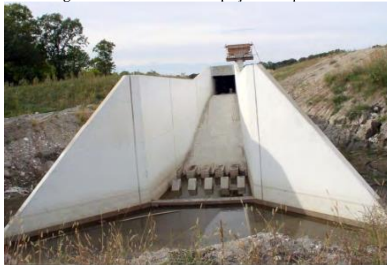
Figura 13 – Bacia de dissipação do tipo SAF.
