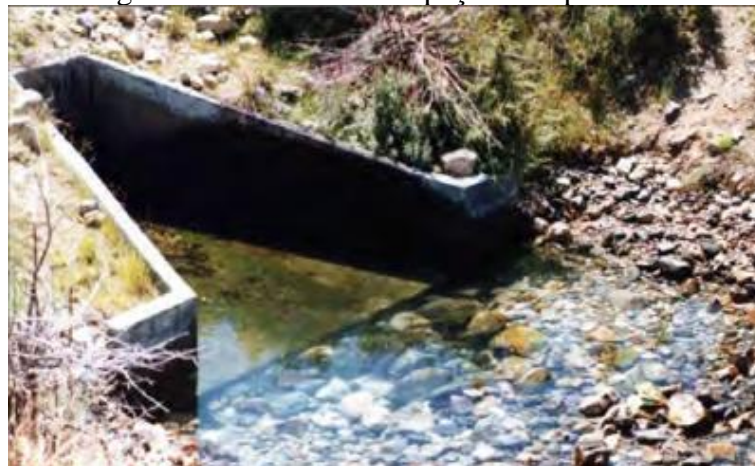
Figura 15 – Bacia de dissipação do tipo PWD.
