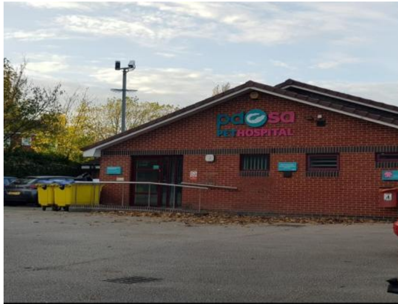
Figura 1- Visão geral da fachada do Hospital Veterinário PDSA Wolverhampton, Inglaterra.
