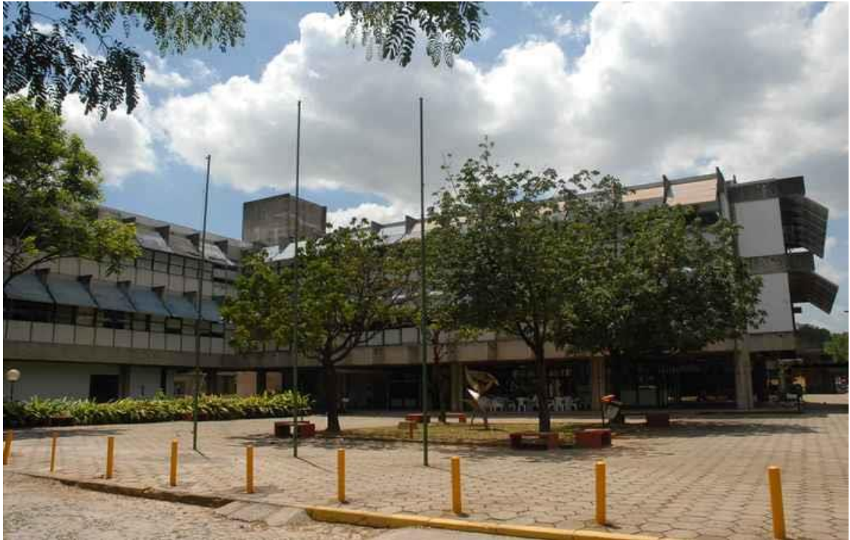
Figura 1 - Entrada principal da Escola de Veterinária da UFMG
