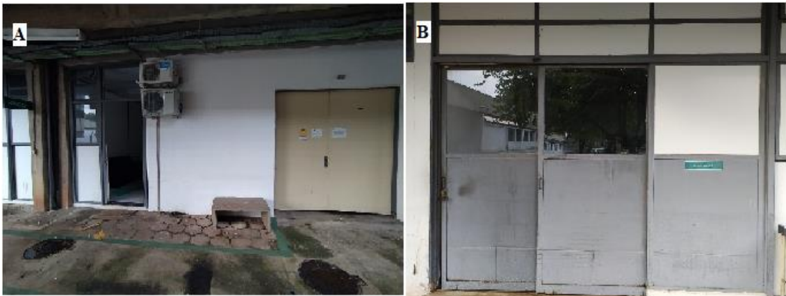
Figura 3 - Vista das portas de acesso do setor de radiologia.
