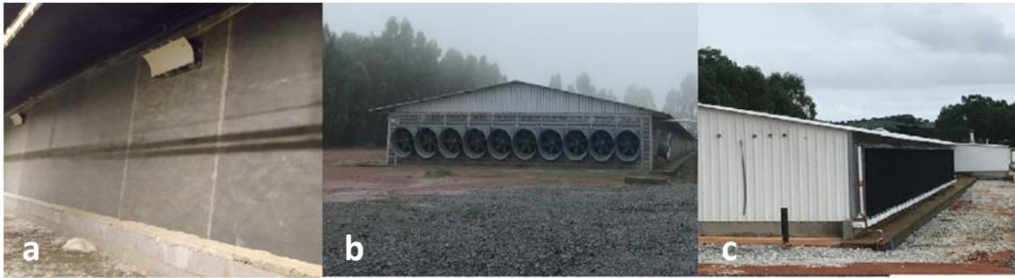
Figura 7 - Galpões de pressão positiva e os de pressão negativa: inlets (a); exaustores (b); placas de entrada de ar (c).
