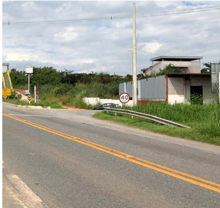
Figura 17: Utilização da defesa metálica para evitar colisões com o poste de energia.
