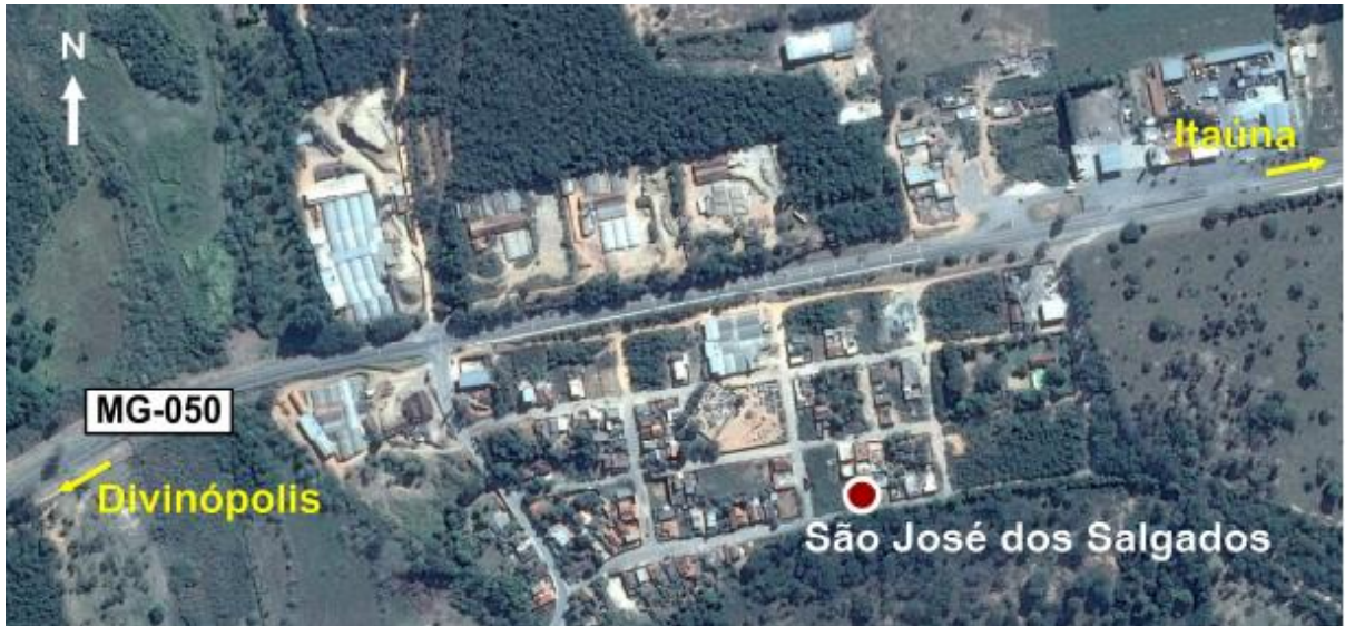
Figura 1: Vista aérea da localização da interseção.
