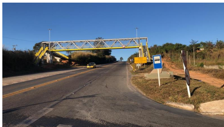
Figura 27: Faixa de aceleração da saída sentido Belo Horizonte.
