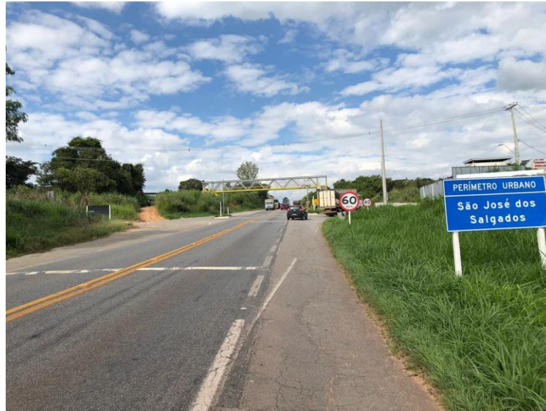
Figura 26: Acesso para o perímetro urbano de São José dos Salgados.
