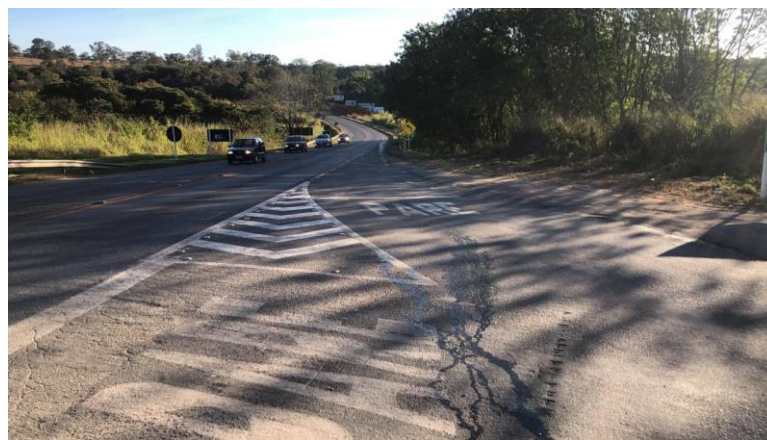
Figura 25: Faixa de aceleração na saída do distrito industrial.
