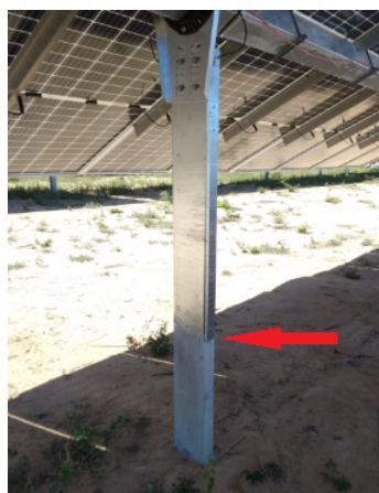
Figura 4.11 – Estaca concretada na usina em operação
