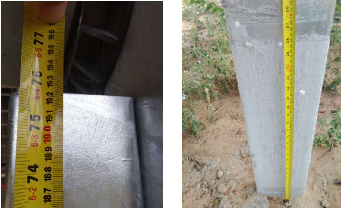
Figura 4.12 – Medição de topo e concreto da estaca
