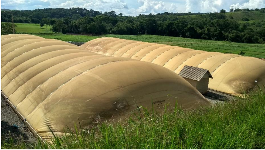
Figura 2: Biodigestores em funcionamento da Fazenda Bom Retiro
