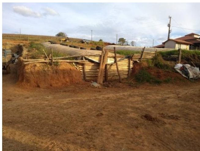
Figura 17. Silo tipo trincheira.
