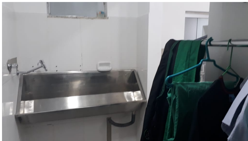
Figura 19 - Sala de Paramentação
