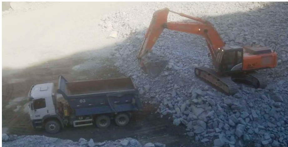
Figura 2 – Carregamento da rocha proveniente do desmonte para abastecimento da planta de britagem.
