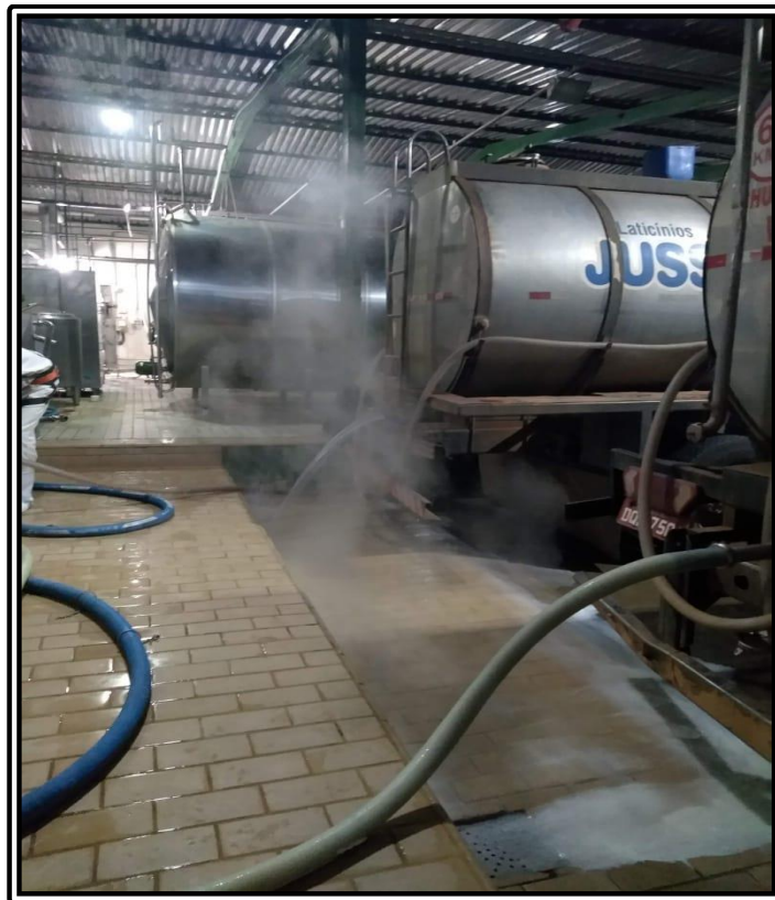
Figura 7 - Diagnóstico de situação dos caminhões. Limpeza do caminhão pela lavagem CIP ( Clean in Place ) do laticínio A (MG).
