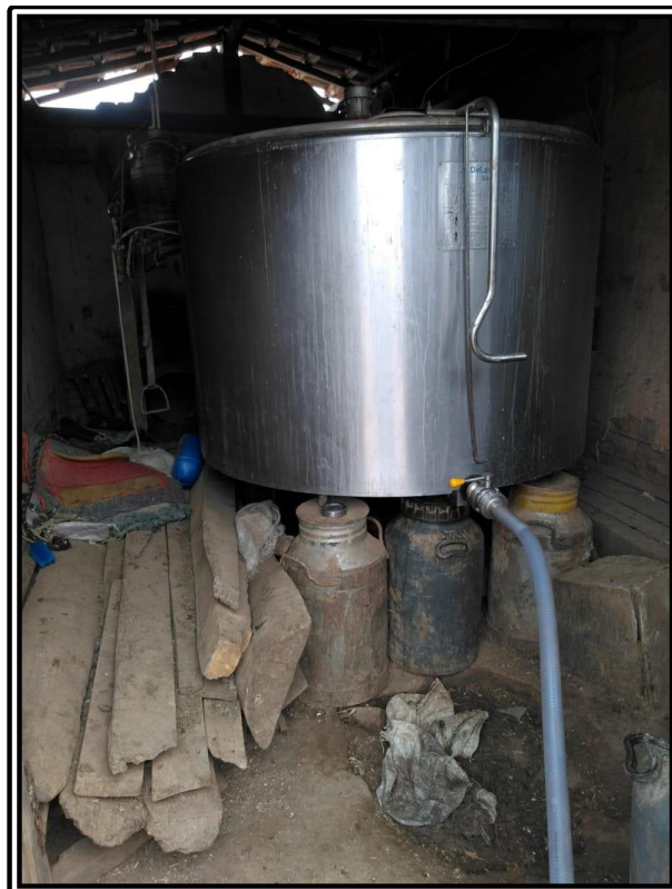
Figura 6 - Diagnóstico de linha. Falha na limpeza e higiene do tanque de expansão do laticínio A (MG).
