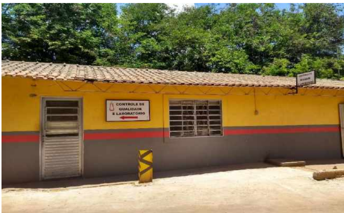
Figura 7 – Laboratório de Controle de Qualidade.
