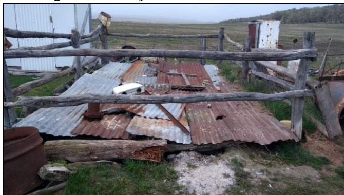
Figura 46 – Poço de descarte de vísceras.
