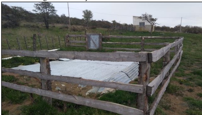
Figura 47 – Poço de descarte de vísceras.
