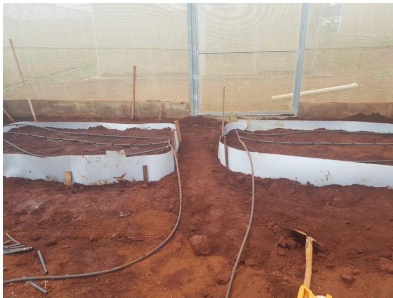
Figura 3. Construção dos canteiros. Etapa na qual foram colocadas as estruturas de plásticos para se reduzir as perdas de água
