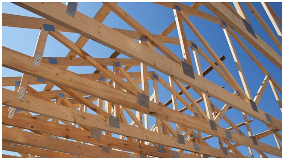
Figura 19 – Tesouras de madeira.
