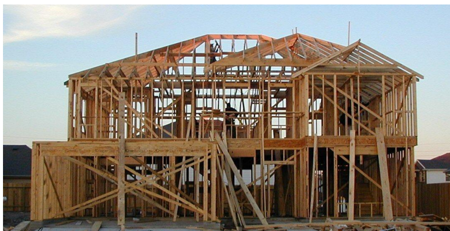
Figura 24 – Estrutura com sistema plataforma em fase de construção.
