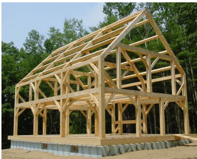
Figura 17 – Exemplo de estrutura aporticada.
