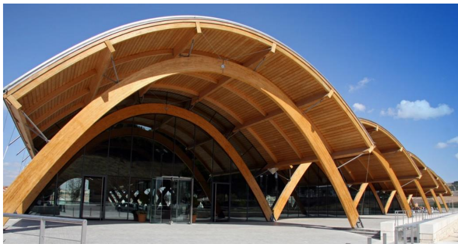
Figura 18 – Pórticos curvos de MLC.
