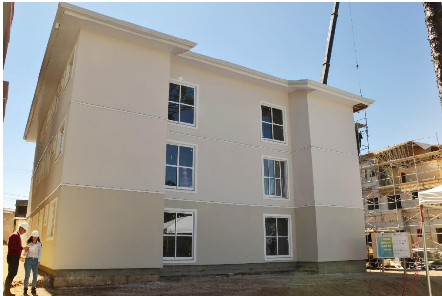
Figura 26 – Edifício em WLF finalizado, Curitiba, PR.
