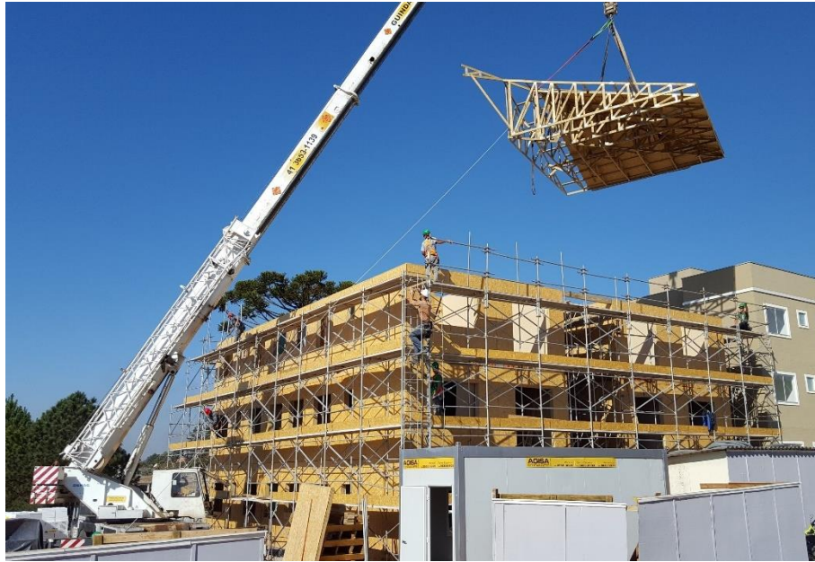
Figura 25 – Etapa de montagem de edifício em WLF, Curitiba, PR.
