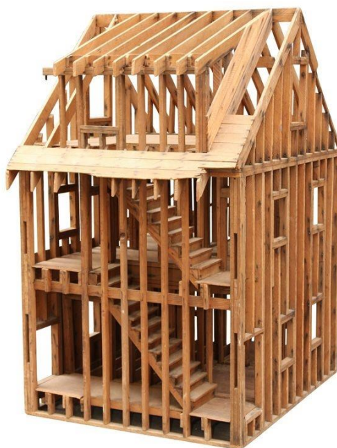
Figura 22 – Maquete de uma casa construída em Balloon Frame.
