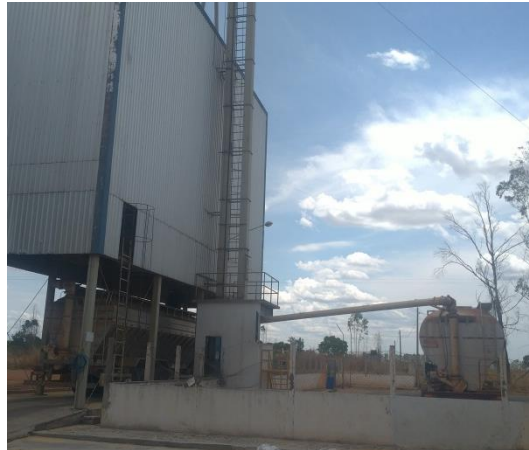
Figura 13: Silos centrais em abastecimento
