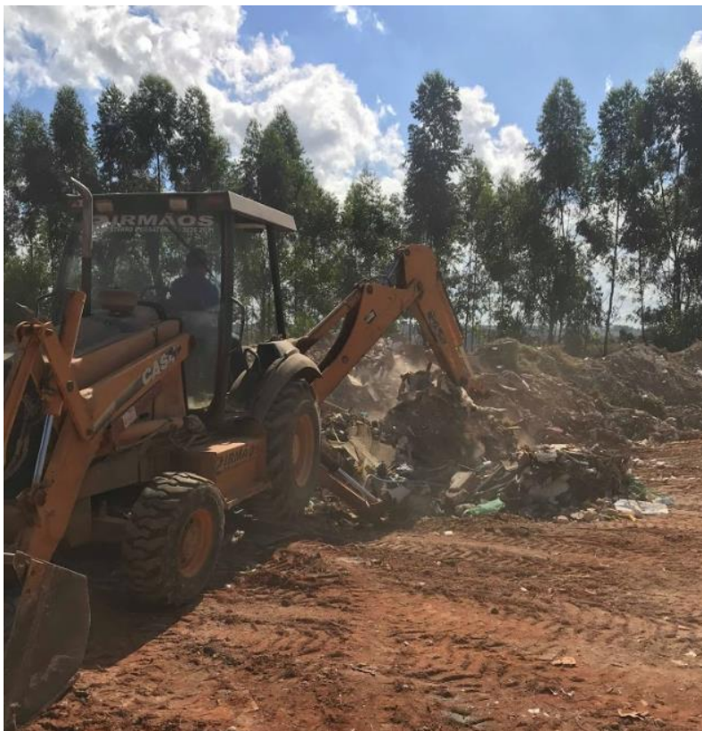
Figura 10 – Retroescavadeira realizando o método do quartejamento da amostra.
