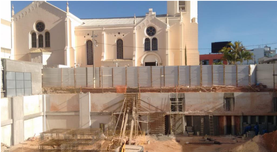
Figura 13 – Obra em execução (fim da escavação).
