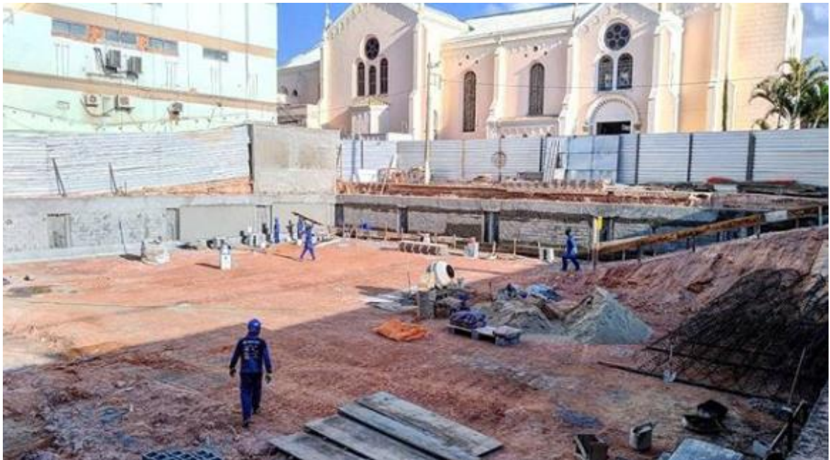
Figura 12 – Obra em execução (primeira escavação).
