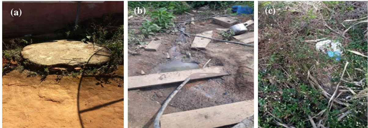
Figura 4. Destinação do esgoto doméstico na comunidade, em São Gonçalo do Sapucaí-MG: fossa rudimentar (a); efluente da lavanderia, pia de cozinha, chuveiro e tanque (b); e fossa séptica (c).
