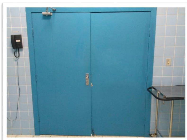
Figura 6 – Fotografia da porta de acesso ao centro cirúrgico do Hospital Veterinário de Pequenos Animais da Universidade Federal de Viçosa – UFV, vista do lado interno.
